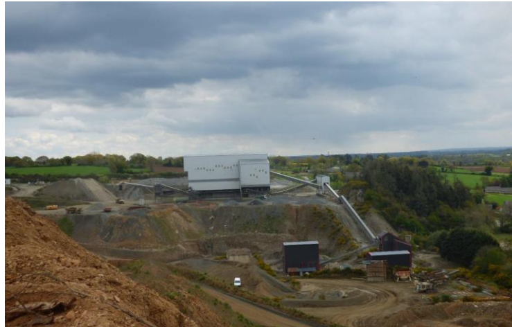
Figure 86 : zone des installations de traitement
